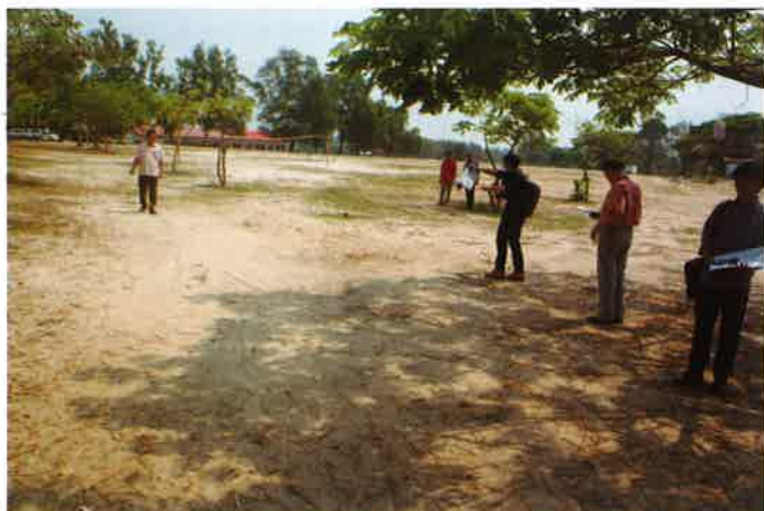
関係者が集まり、校庭の建設予定地を確定。
