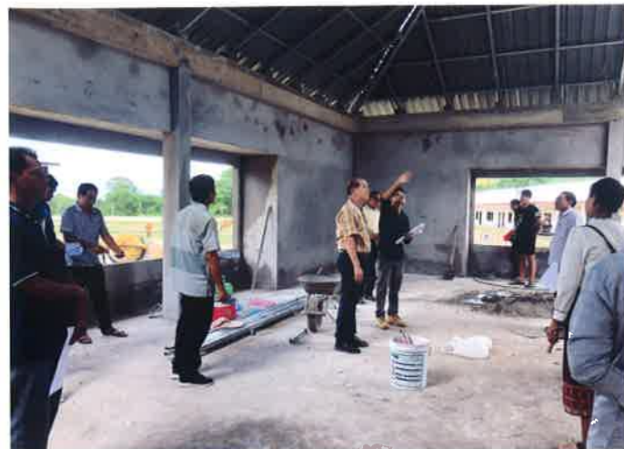
建設中の図書館を視察。事務局長の野口からの説明に完成後のイメージが膨らみます。
